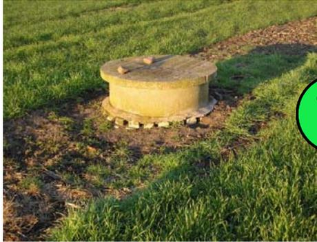
Fig. 32 – Pozzo adeguatamente protetto (foto Harper Adams).
