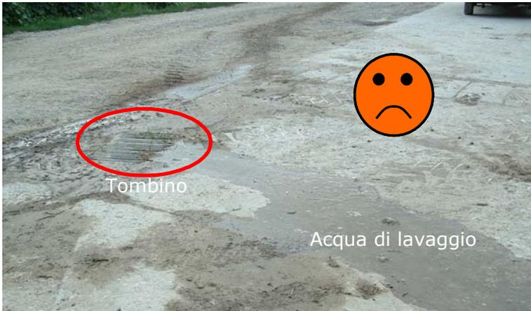
Fig. 103 – Acque di lavaggio immesse direttamente nella rete fognaria
