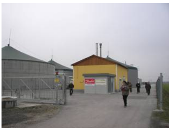
Impianto a biogas e CHP
