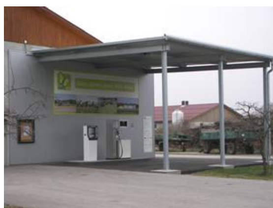
Stazione di rifornimento del biometano
